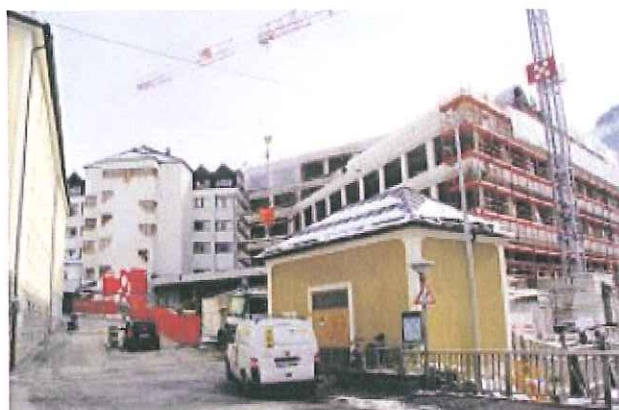
Das Trafohaus verschwindet. Damit „öffnet“ sich der Krankenhauskomplex in Richtung Ortszentrum. Bild: SW/migu
