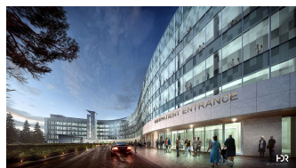
ZÜBLIN, US-Militärhospital, Weilerbach
