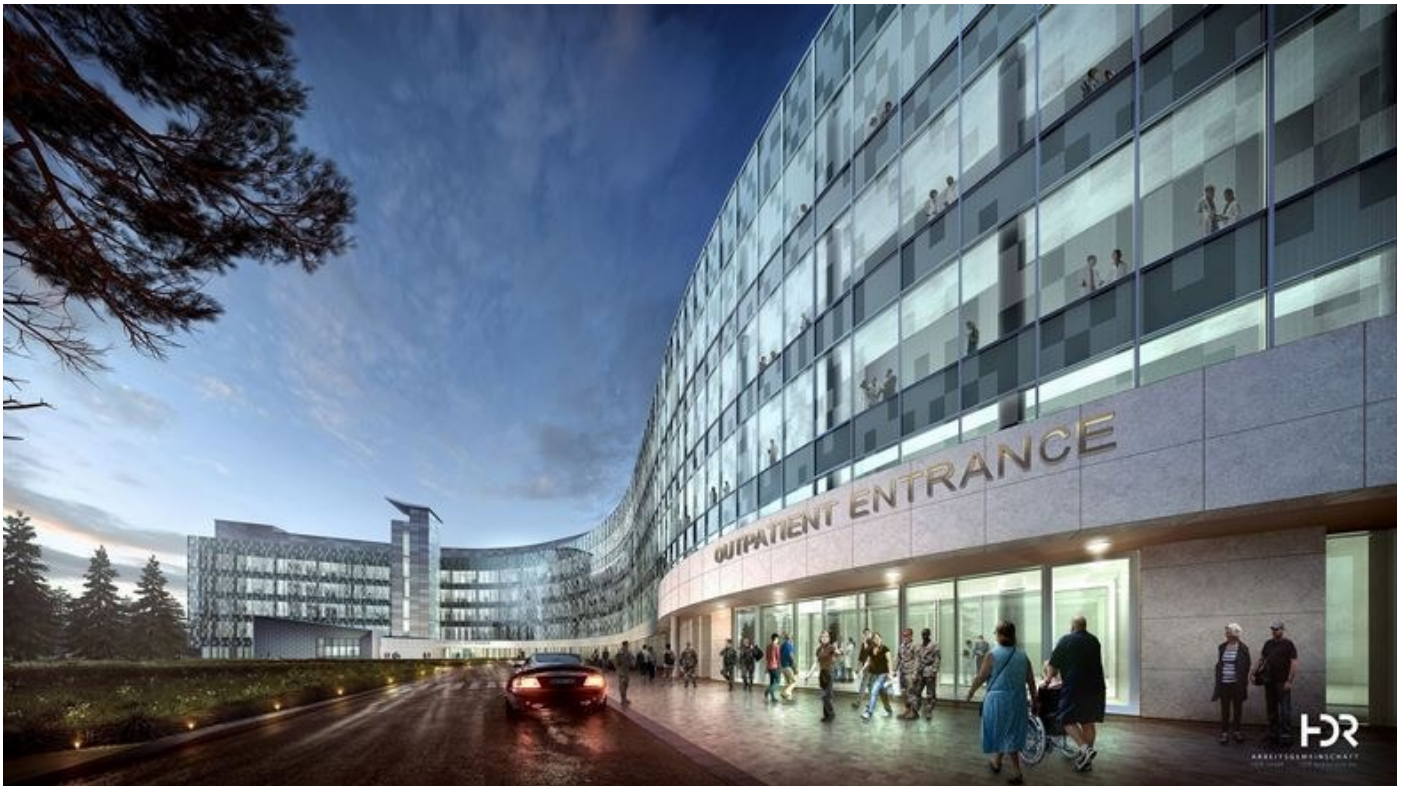
ZÜBLIN, US-Militärhospital Weilerbach
